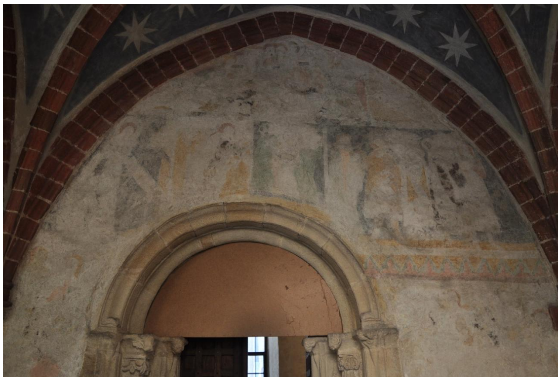
15. Třetí pole christologického cyklu – západní stěna
