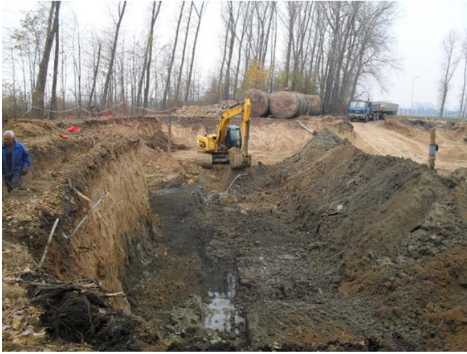
Obrázek č.4 Výkopové práce v oblasti sanace
