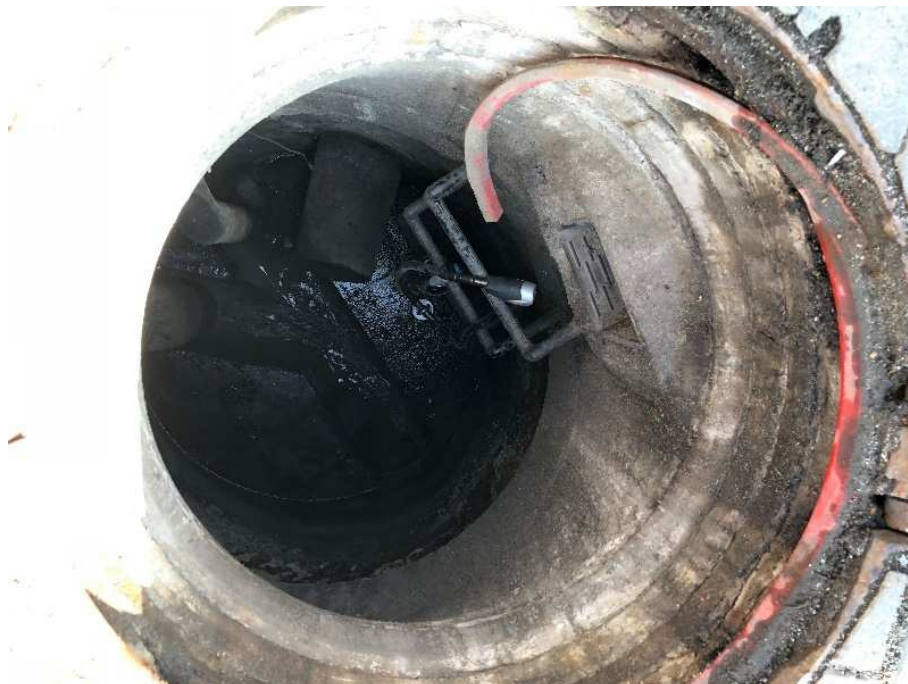
Obrázek 4.11 Detail umístění prvního OdaLogu L2
