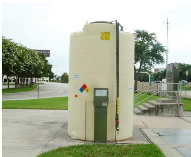
Obrázek 2.6 Stanice s dávkováním dusičnanu vápenatého do kanalizace [26]
