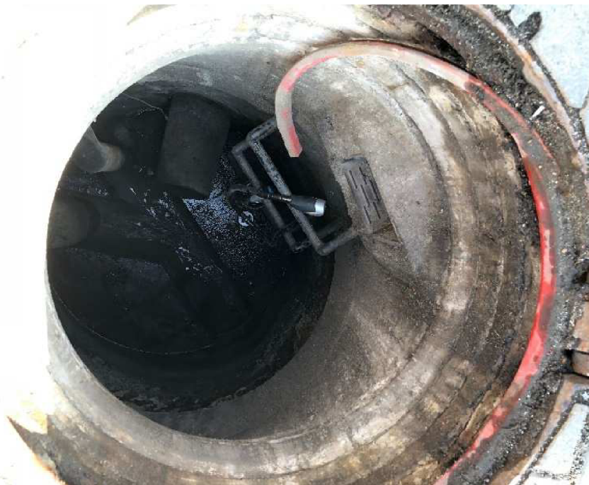
Obrázek 4.11 Detail umístění prvního OdaLogu L2
