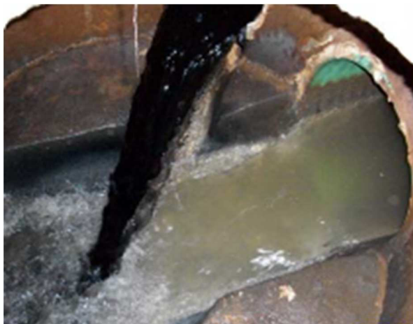
Obrázek 2.5 Přítok odpadní vody ošetřené chloridem železitým s typicky černým zbarvením [26]
