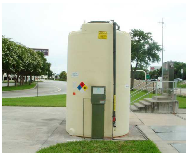
Obrázek 2.6 Stanice s dávkováním dusičnanu vápenatého do kanalizace [26]
