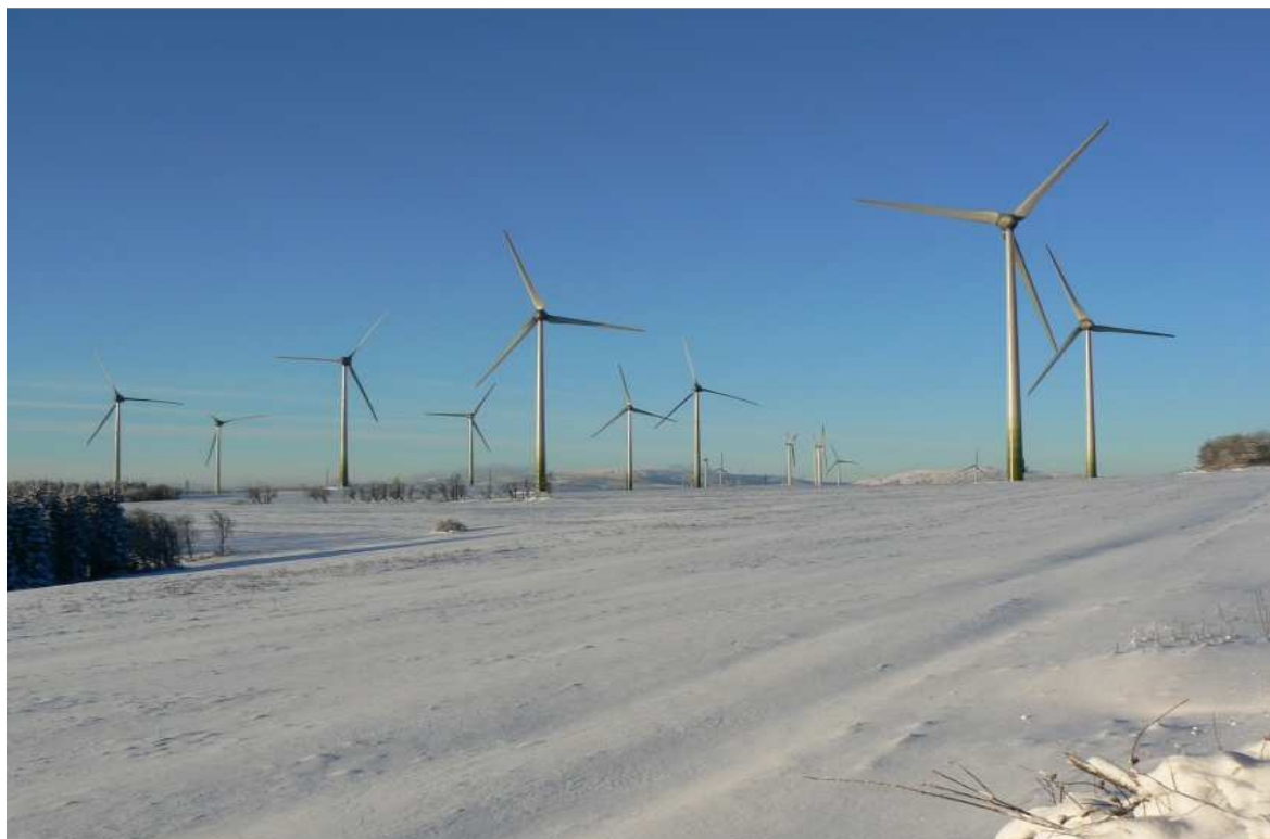
Obr.č. 10 Větrný park chomutov
