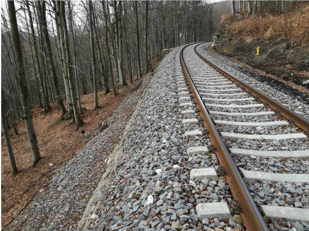
Obr. 3: Pohled na odřez s opěrnou zdí, km 22,200 000
