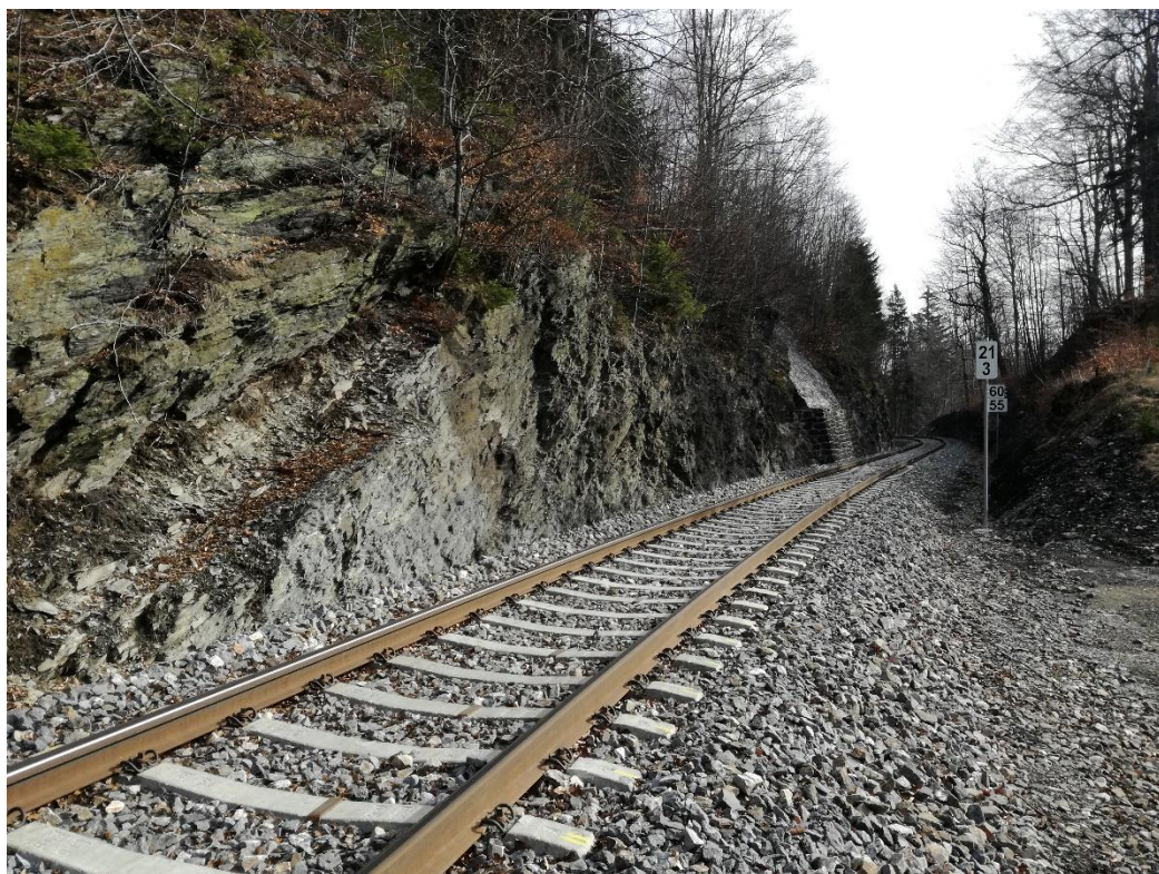
Obr. 2: Pohled na skalní stěnu, km 21,300 000
