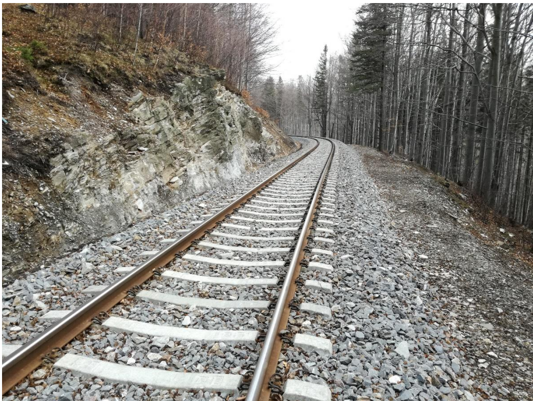
Obr. 4: Skalní odřez, km 22,800 000
