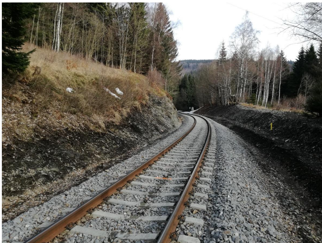
Obr. 1: Začátek úseku, km 20,900 000
