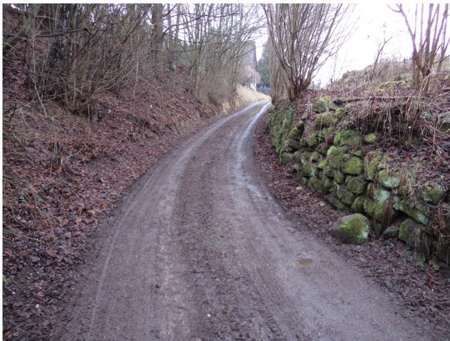
Obrázek 8: Opěrná zed' podél PC1
