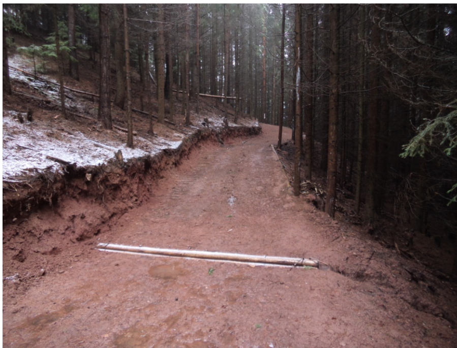
Obrázek 14: Úprava cesty LC15 se zbudovanou dřevěnou svodnicí
