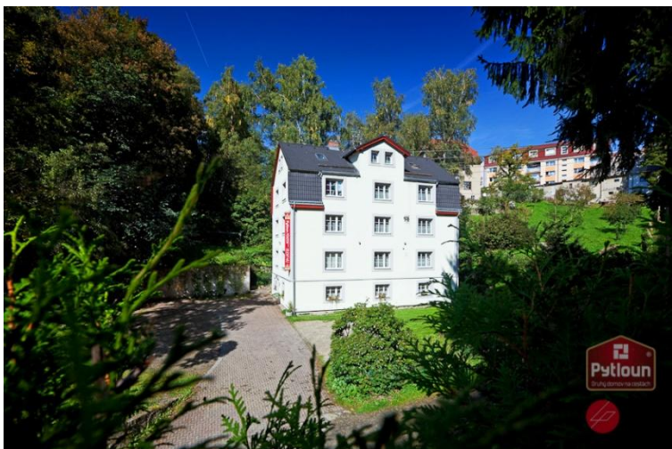
Obr. 16: PYTLOUN PENZION ZELENÝ HÁJ Zdroj: Liberec-ubytovani.cz (2013h)
