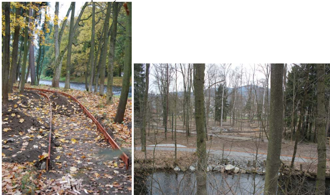
Budování zpevněných cest v centrální části ostrova, tzv. „lodi“ / podzim 2012, 2013 foto: soukromý archiv Andrea Staňková, 2012-13
