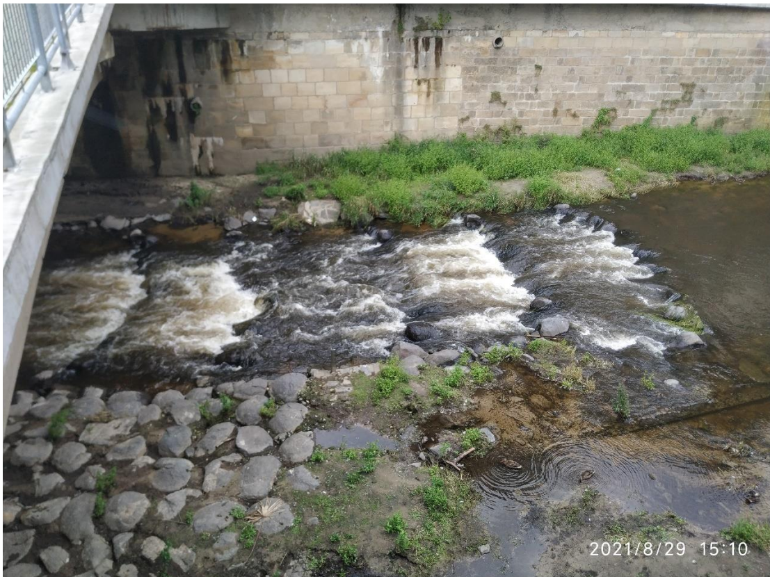
Příloha 8: Rybí přechod Hřensko – zachovalá funkčnost po 7 letech (vlastní archiv, 2021)
