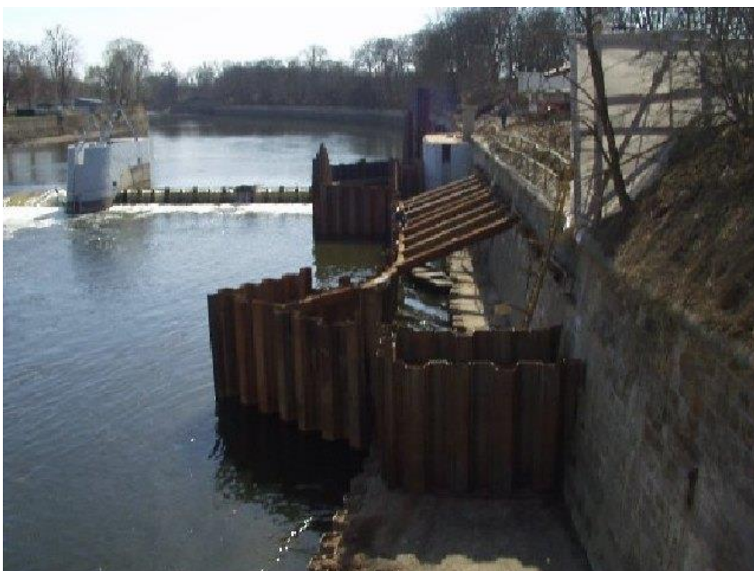
Příloha 10: Rybí přechod na jezu Terežín – realizace (archiv Povodí Ohře, s. p., 2003)
