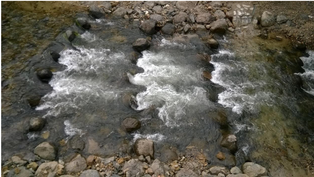
Příloha 5: Rybí přechod Hřensko – po dokončení (vlastní archiv, 2014)
