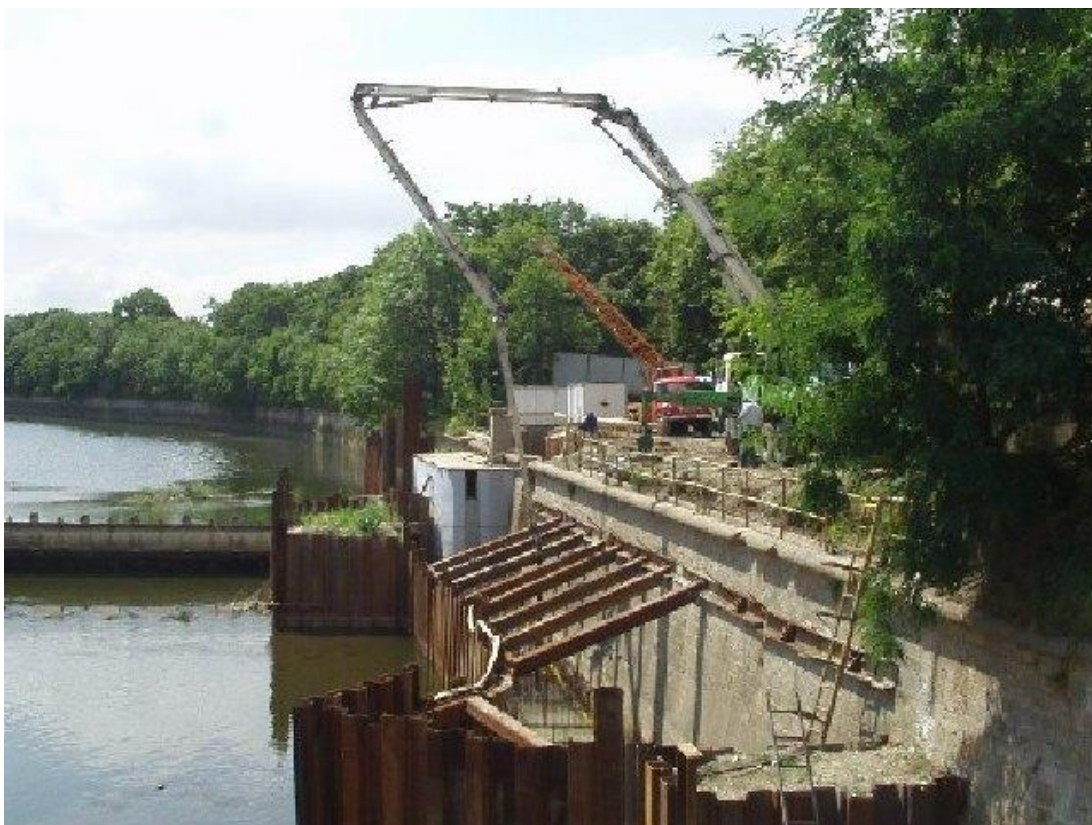
Příloha 11: Rybí přechod na jezu Terežín – realizace (archiv Povodí Ohře, s. p., 2003)
