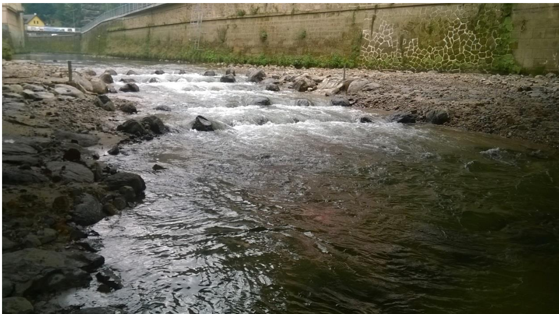
Příloha 4: Rybí přechod Hřensko – po dokončení (vlastní archiv, 2014)
