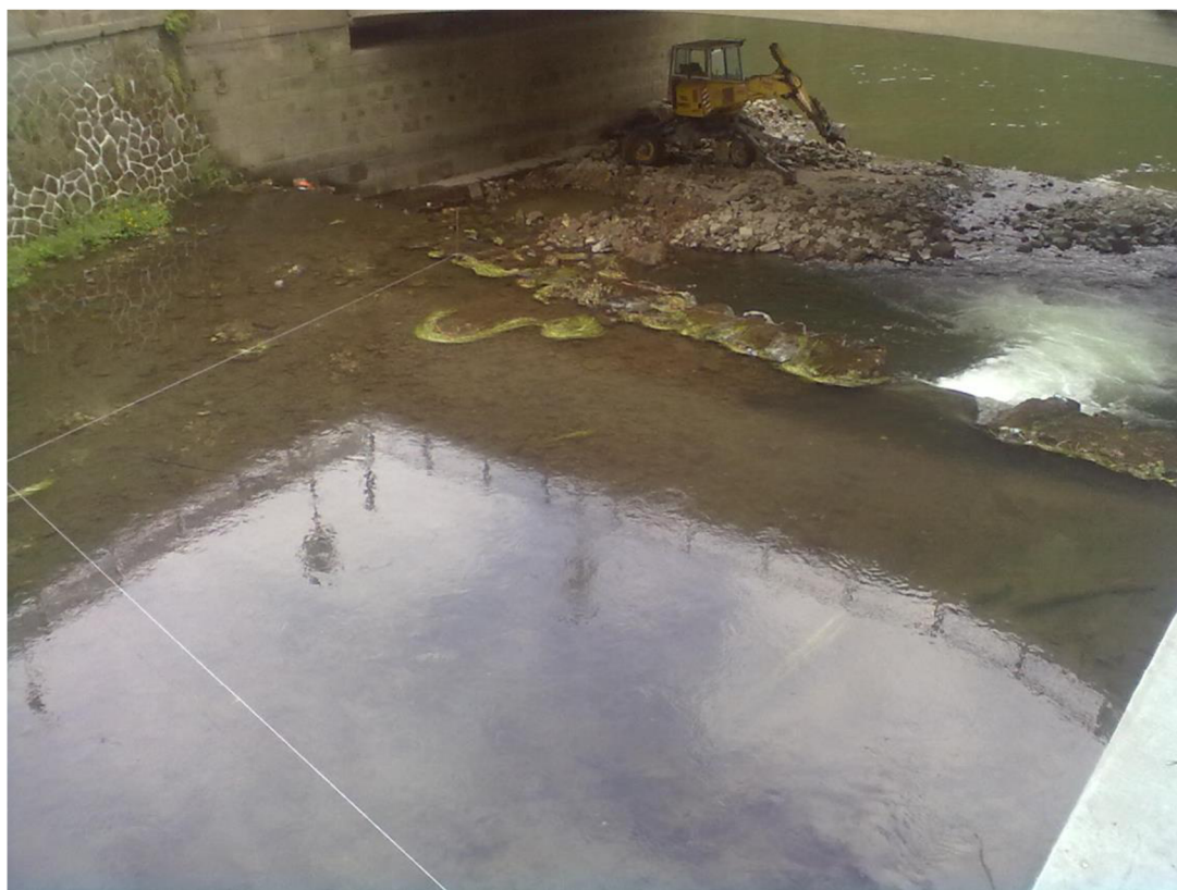
Příloha 1: Rybí přechod Hřensko – původní stav (vlastní archiv, 2014)
