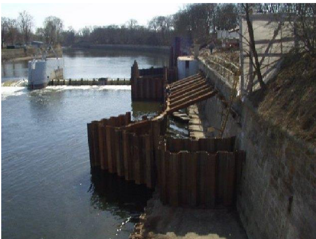
Příloha 10: Rybí přechod na jezu Terezín – realizace (archiv Povodí Ohře, s. p., 2003)
