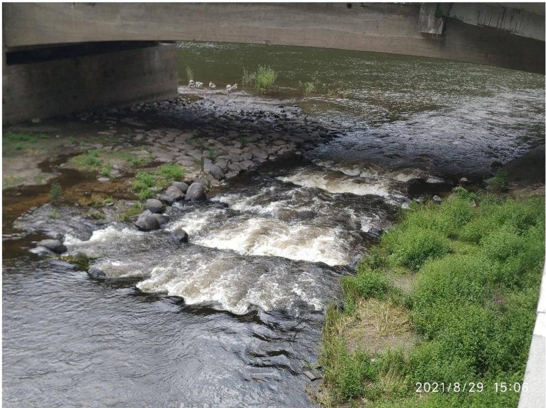
Příloha 7: Rybí přechod Hřensko – zachovalá funkčnost po 7 letech (vlastní archiv, 2021)
