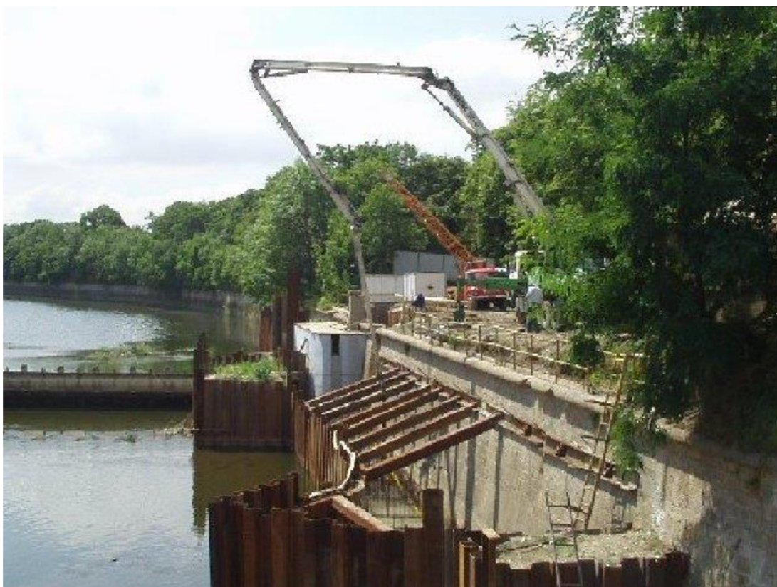
Příloha 11: Rybí přechod na jezu Terežín – realizace (archiv Povodí Ohře, s. p., 2003)
