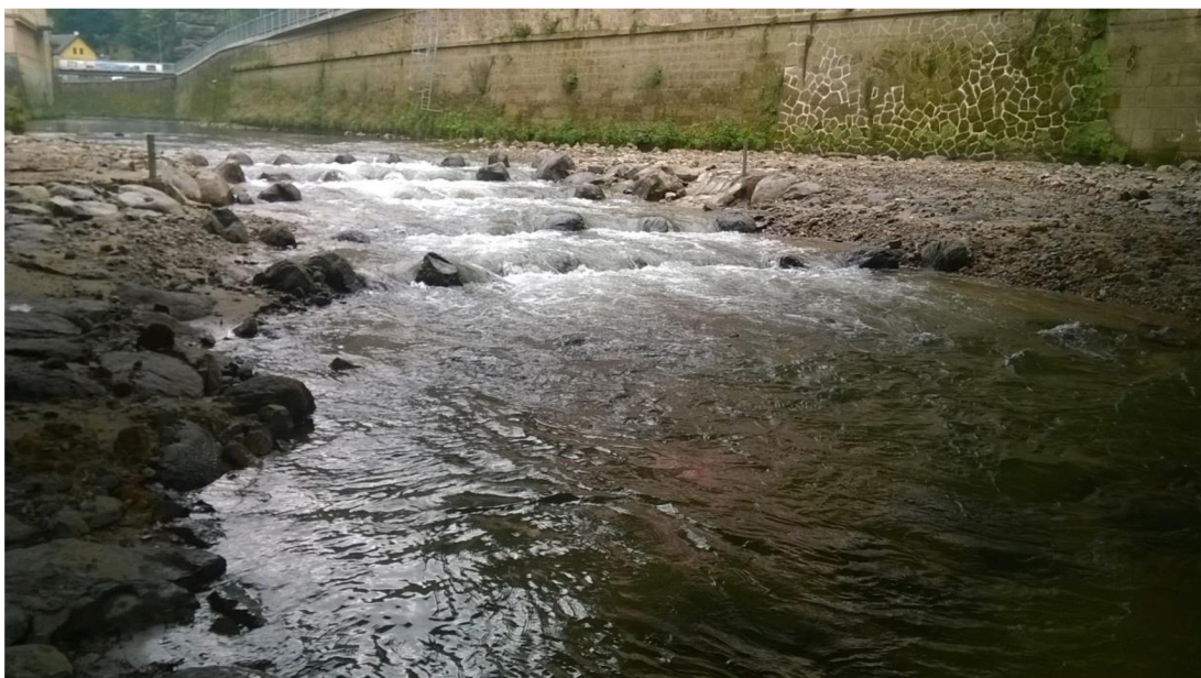
Příloha 4: Rybí přechod Hřensko – po dokončení (vlastní archiv, 2014)
