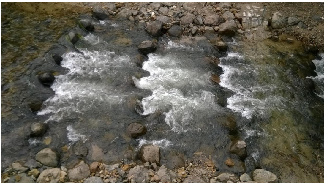
Příloha 5: Rybí přechod Hřensko – po dokončení (vlastní archiv, 2014)
