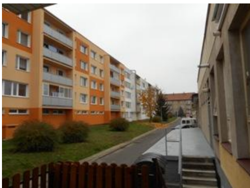
Obr. č. 13 - Pohled z vyvýšené zahrádky cukrárny u sídliště Jaselská.
