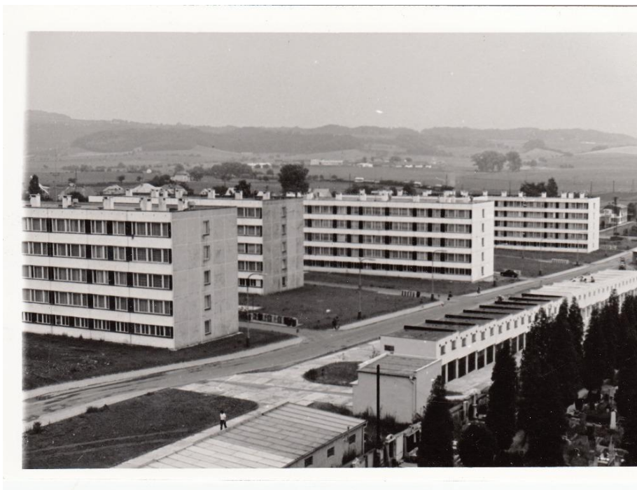
Obr. č. 4 - Pohled na vznikající 5tí podlažní panelové domy, patrné funkční členění ploch. Střídají se domy třimodulové s dvoumodulovými – sídliště Lidická.
