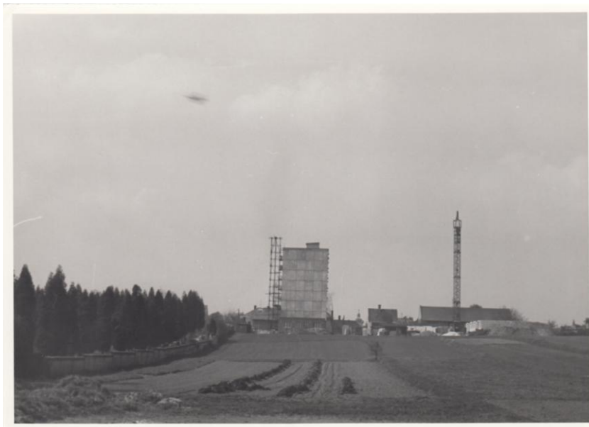
Obr. č. 2 - Pohled na první panelový dům z počátku výstavby sídliště Lidická. V levé části je patrný hřbitov.
