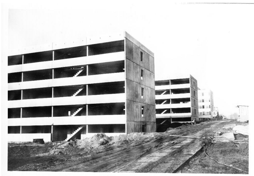
Obr. č. 3 - Panelový dům s jednoramenným schodištěm - sídliště Lidická.
