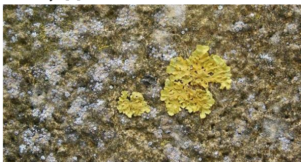
Obr 2.1: Ilustrační foto, mírně zvětšený detail silně napadeného povrchu zateplovacího systému. Původní zelený porost řas postupně překrývají lišejníky různých druhů, velikostí a barev. Převzato z [4].
