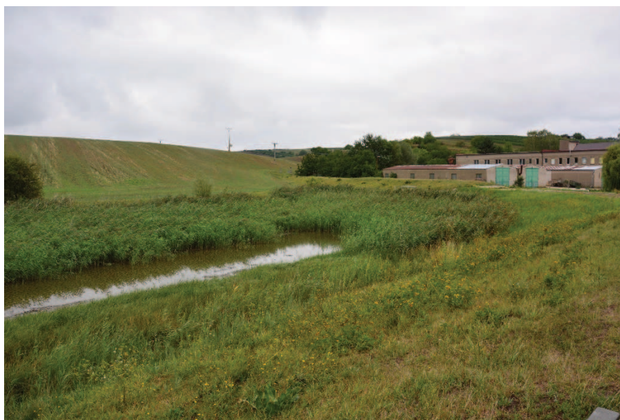
Obr. 18 – Polosuchá retenční nádrž Čejkovice I.
