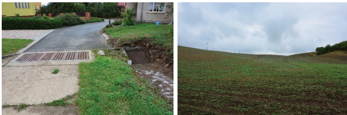
Obr. 19 - KP1=KB1 v místě zaústění do dešťové kanalizace (vlevo) a pohled na jeho sběrné povodí (vpravo)
