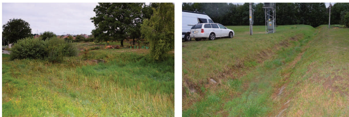
Obr. 20 - Pohled na suchou nádrž s výpustným objektem (vlevo) a svodný příkop do v.t. Prušánka (vpravo)
