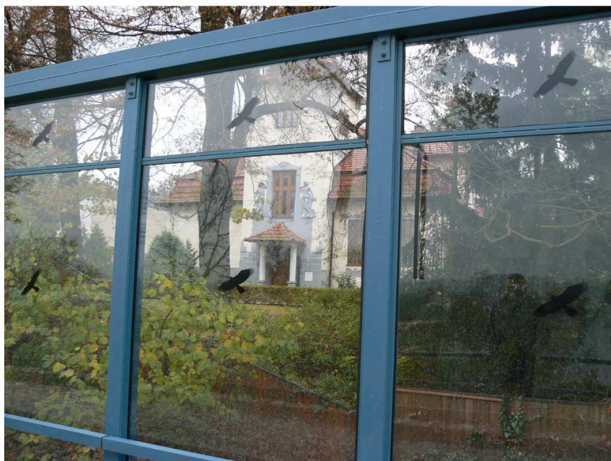
Obr. 2.10.2.2.2. Protihluková stěna před občanskou zástavbou
