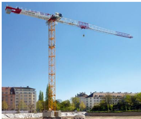
Obrázek 38 - Věžový jeřáb 202 EC-B 10 Litronic (zdroj [14])
