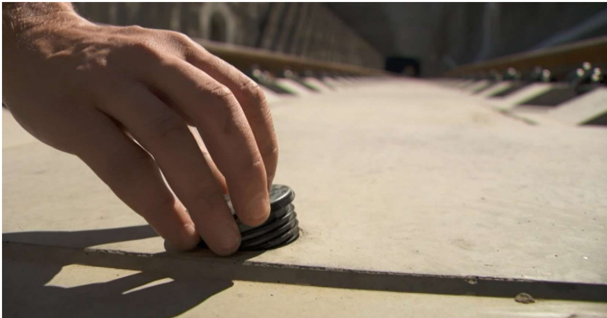
obr. č. 61: Osazení plastových krytek do otvorů [34]
