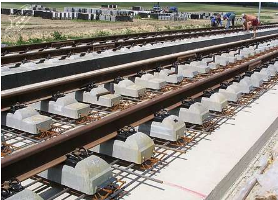
obr. č. 63: Kolejový rošt konstrukce typu Rheda 2000 [23]
