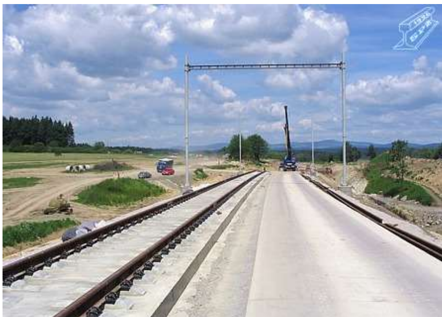
obr. č. 65: Zabetonovaná nosná deska (vlevo) a zhotovená roznášecí vrstva (vpravo) [23]
