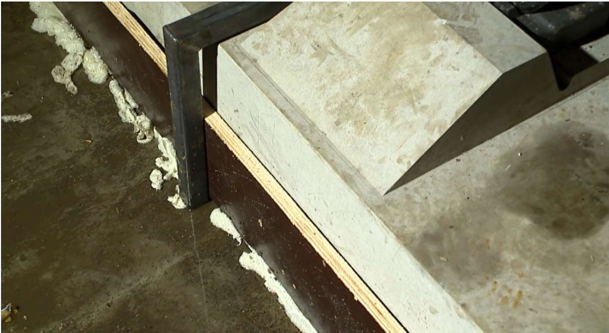
obr. č. 58: Osazení bednění a jeho utěsnění [34]
