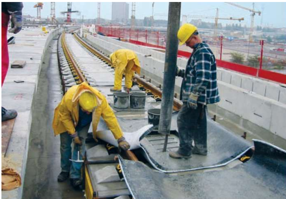
obr. č. 60: Betonáž desky [24]
