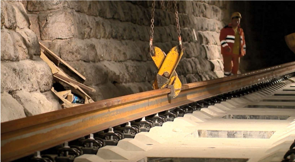
obr. č. 55: Ukládání kolejnic [34]
