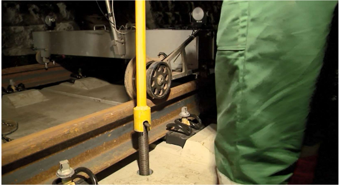
obr. č. 56: Dotažení rektifikačních šroubů a kontrola polohy koleje [34]
