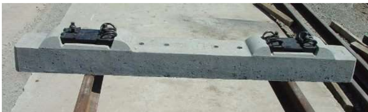
obr. č. 39: Přejímový pražec pro konstrukci Rheda 2000 [20]
