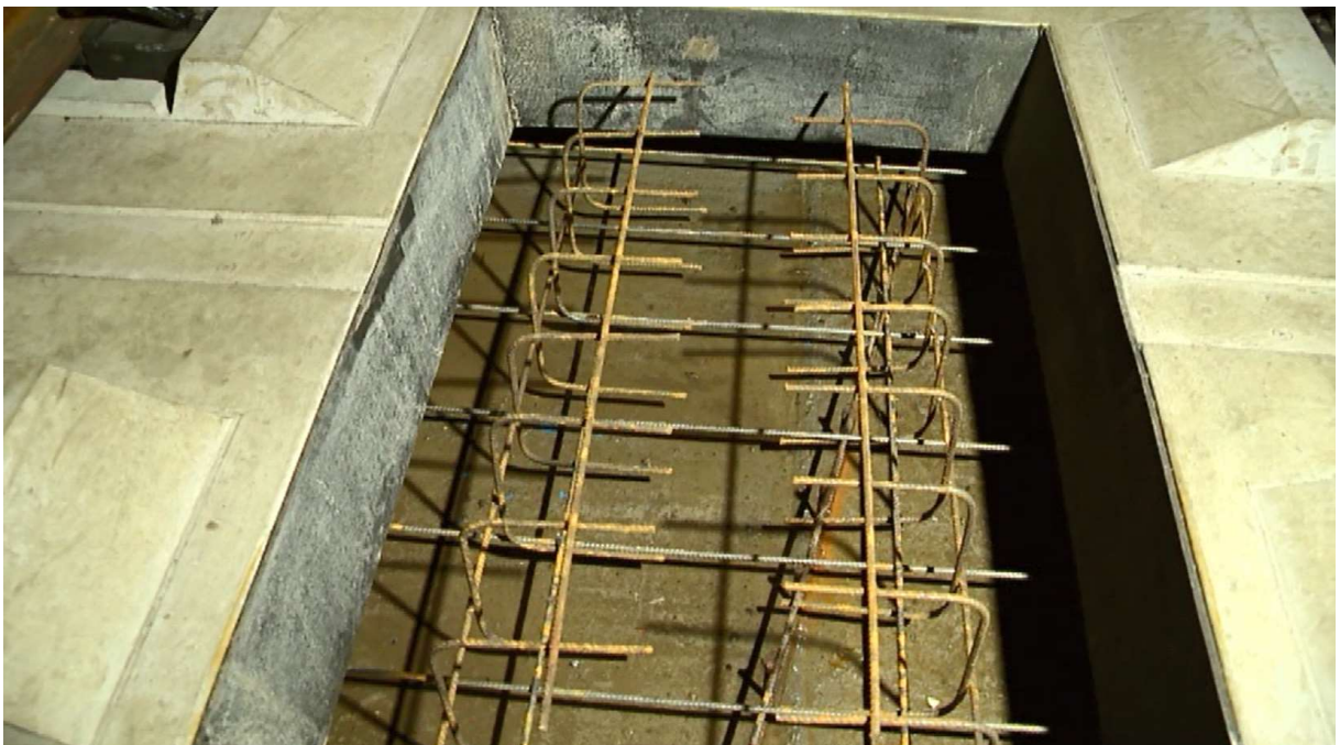
obr. č. 57: Armatura v otvorech desky [34]
