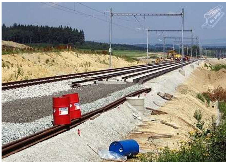
obr. č. 66: Stmelení předštěrkované přechodové oblasti [23]
