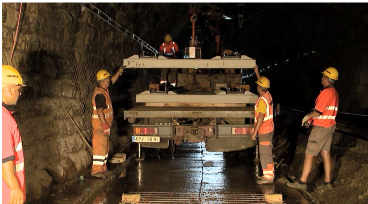
obr. č. 53: Pokládka desek PJD automobilovým jeřábem [34]
