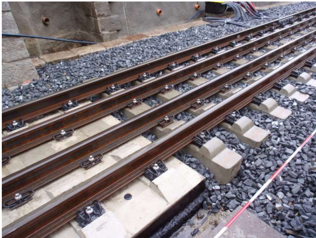
obr. č. 29: Přechodová oblast ÖBB-PORR [20]
