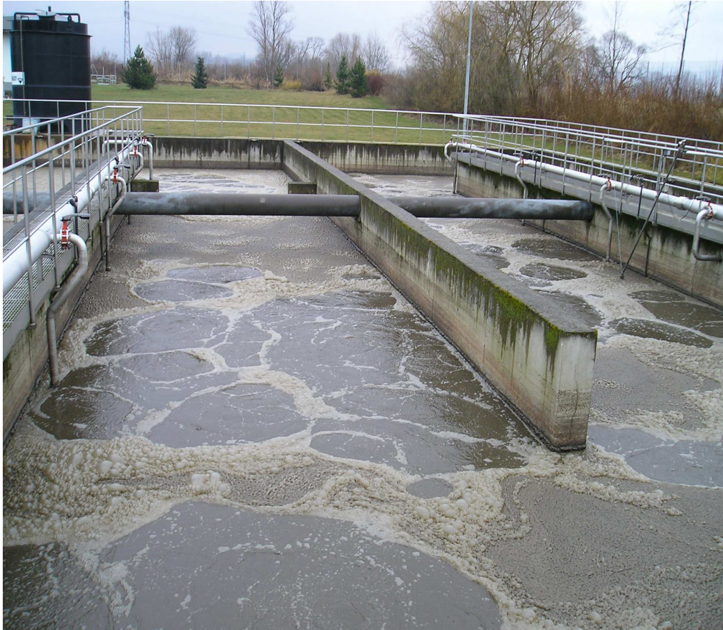
Obr. 5 Aktivační nádrž (ČOV Šumperk)
