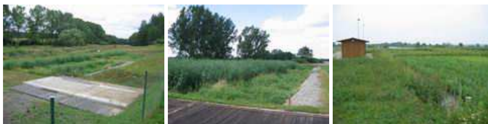
Obr. 17 kořenová čistírna odpadních vod [15]
