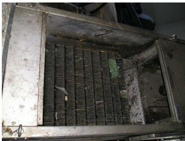
Obr. 3 Strojní česle jemné
