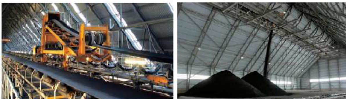
Obrázek 17 Zakládací vůz včetně pojízdných kolejnic při procesu zakládání materiálu [2]
