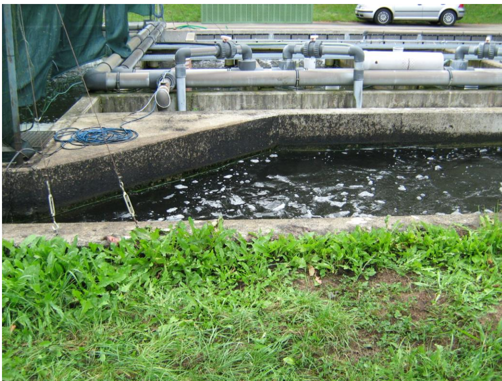
Obr. 5: Odběrové místo – stěna (foto: L. Mareš)
