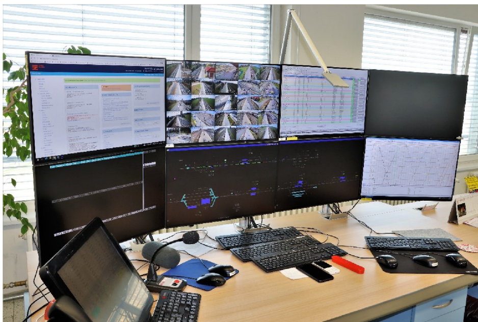
Obr. 3.4 Pracoviště výpravčího na RDP Olomouc
