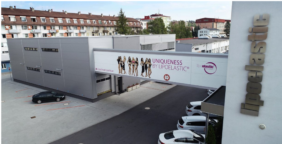
Obr. 2.4 - Budova logistického centra společnosti Lipoelastic a.s.
