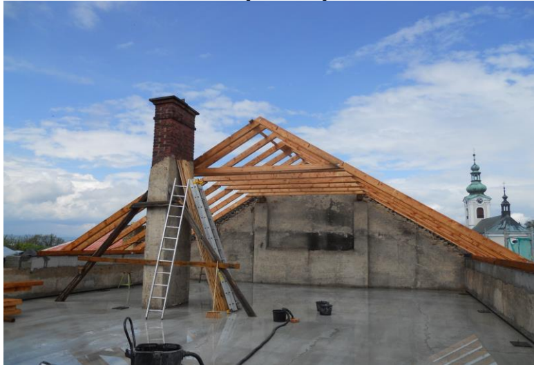
Obrázek 3 Rekonstrukce půdních prostor ZŠ Komenského
