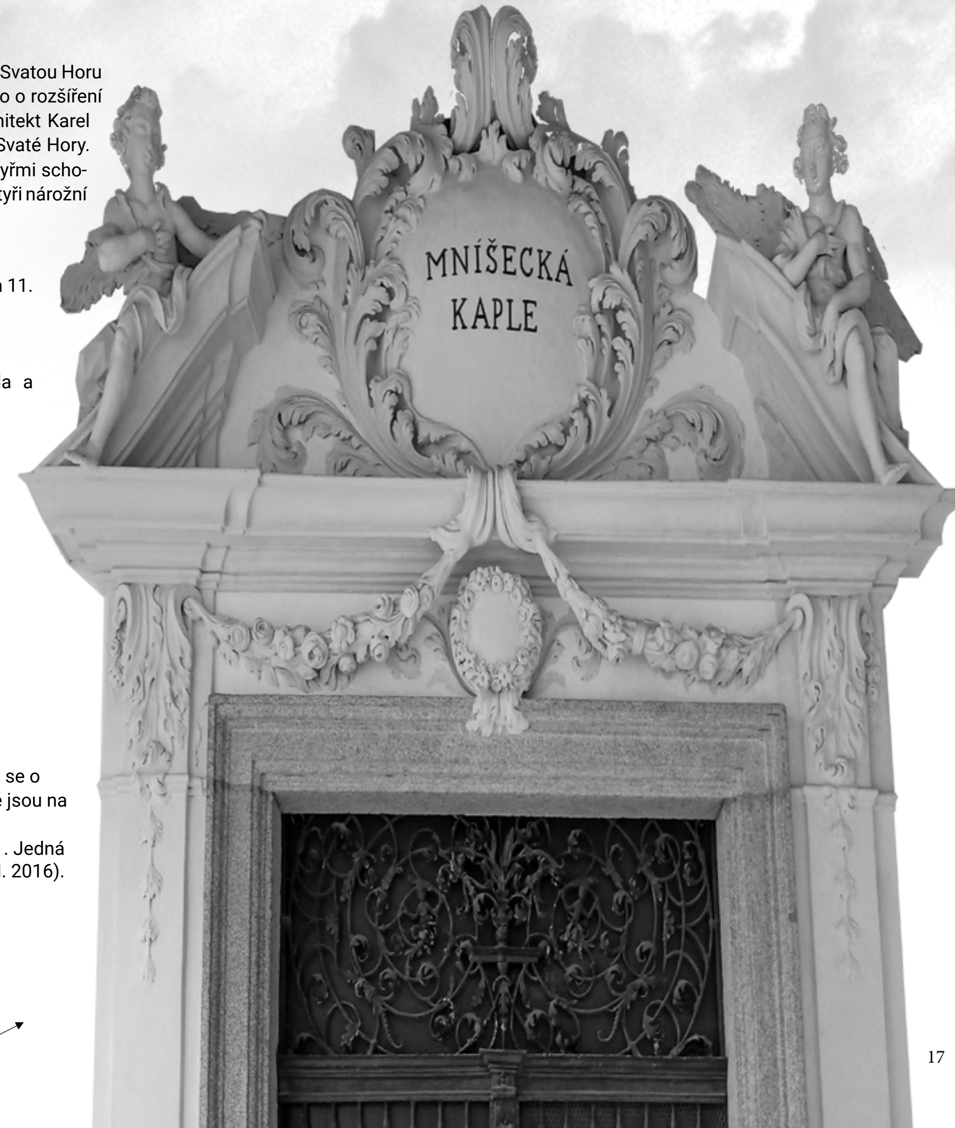
Obrázek č. 29: Portál mníšecké kaple Zdroj: Foto autor
