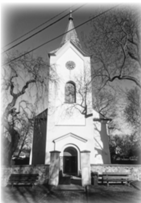
Obrázek č. 77: Kostel Nanebevzetí Panny Marie, Kytín Zdroj: Foto autor
