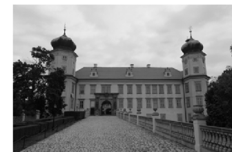
Obrázek č. 74: Zámek Mníšek pod Brdy, 2021 Zdroj: Foto autor
