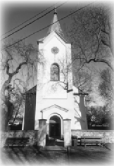
Obrázek č. 77: Kostel Nanebevzetí Panny Marie, Kytín Zdroj: Foto autor
