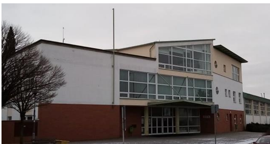
Obr. 5. Nová budova školy Javornická
