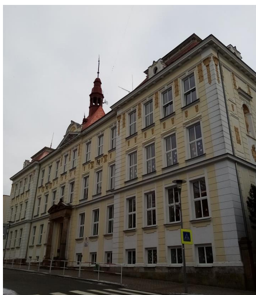
Obr. 2. Budova Chlapecké školy
