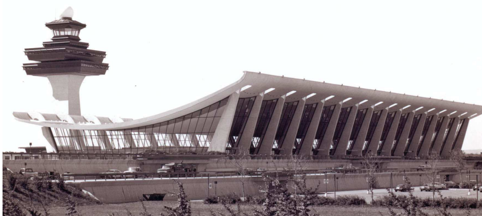
Obr. 2.2: Příklad visuté lanové konstrukce jednoduché křivosti – letištní terminál v Dulles
