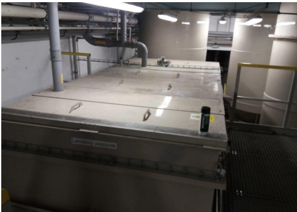
Obrázek 11: Spodní část lamelového usazováku (Vlastní zdroj)
