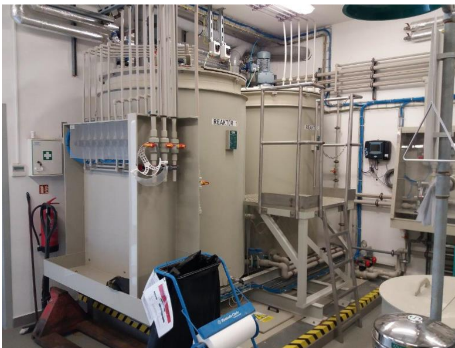
Obrázek 19: Pohled na dva reaktory, kde dochází k rozkladu hormonálních látek (Vlastní zdroj)
