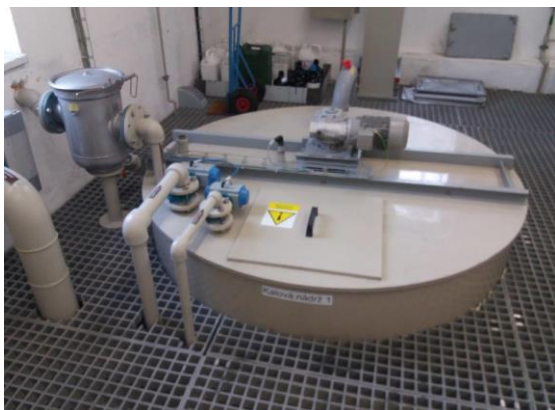
Obrázek 8: První kalová nádrž (Vlastní zdroj)
