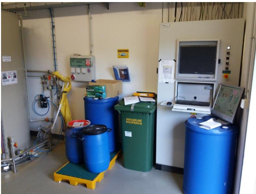
Obrázek 18: Ovládací panel pro nastavení postupů čištění (Vlastní zdroj)
