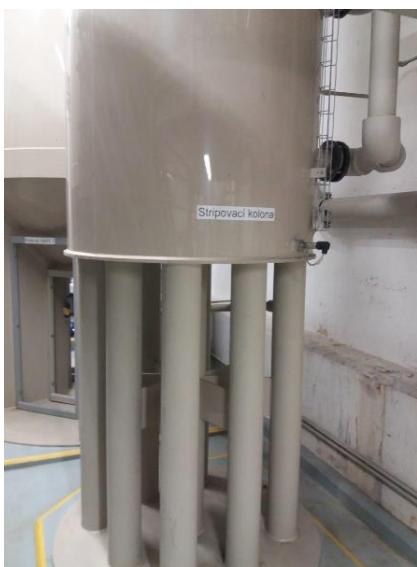
Obrázek 13: Stripovací kolona (Vlastní zdroj)
