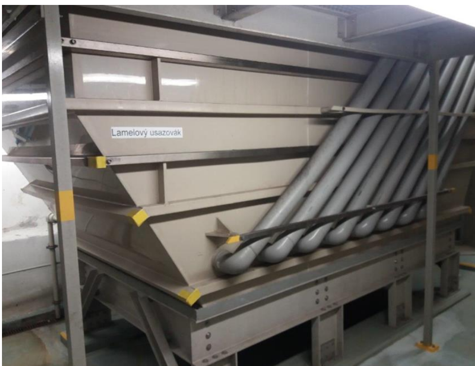
Obrázek 11: Spodní část lamelového usazováku (Vlastní zdroj)
