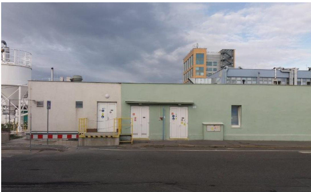
Obrázek 5: Pohled na ČOV v areálu (Vlastní zdroj)
