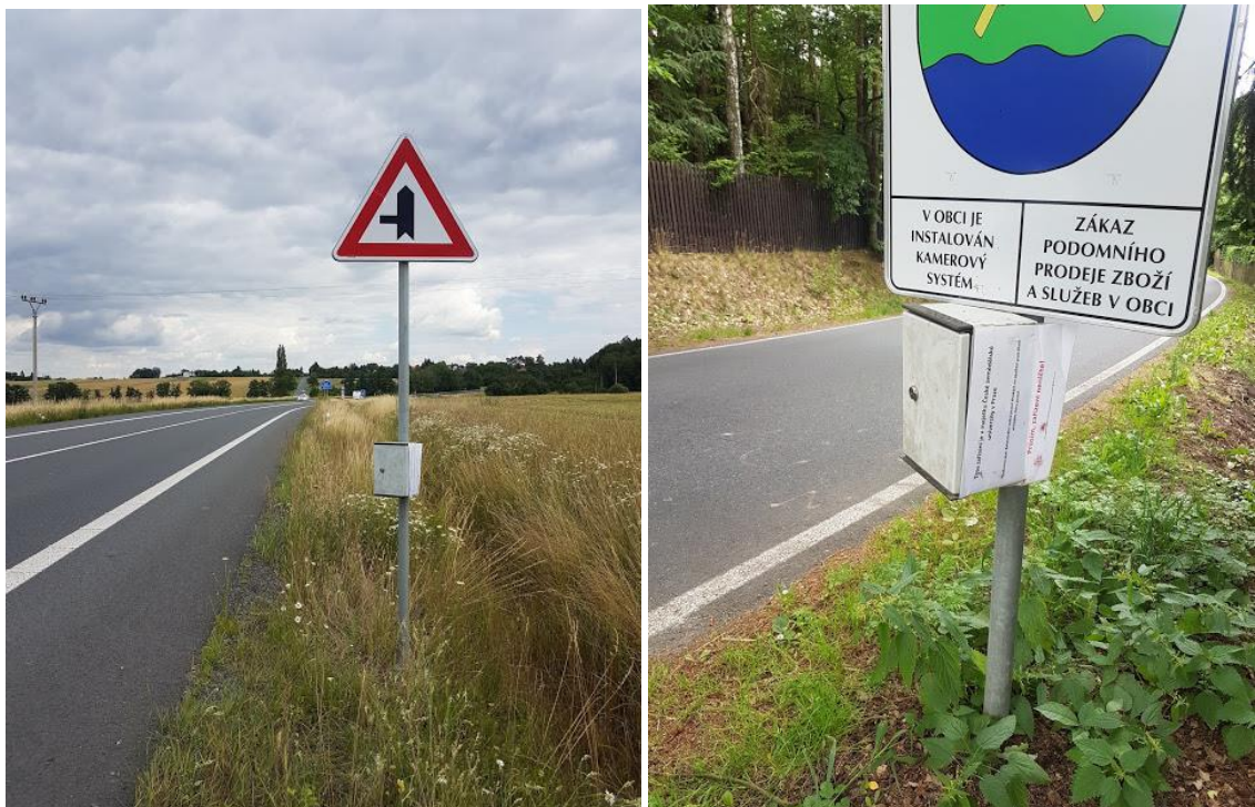
Obrázek 10: Radar Sierzega nainstalovaný u silnice (zdroj: vlastní foto)
