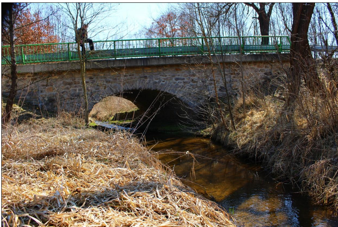
Obr. 52. Most, silnice Chvalšiny – Brloh, zdroj: vlastní (8.4.2018)
