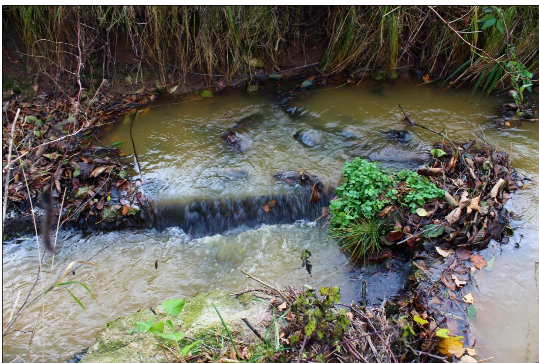
Obr. 35. Polovegetační tvárnice, drobné břehové nátrže (do 5 m), zdroj: vlastní (2.11.2017)
