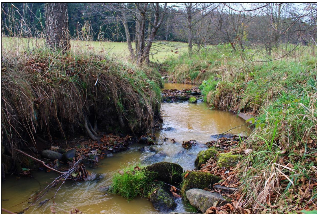
Obr. 33. Zpevnění dna kamenným pohozen, přeřinatý úsek, zdroj: vlastní (2.11.2017)
