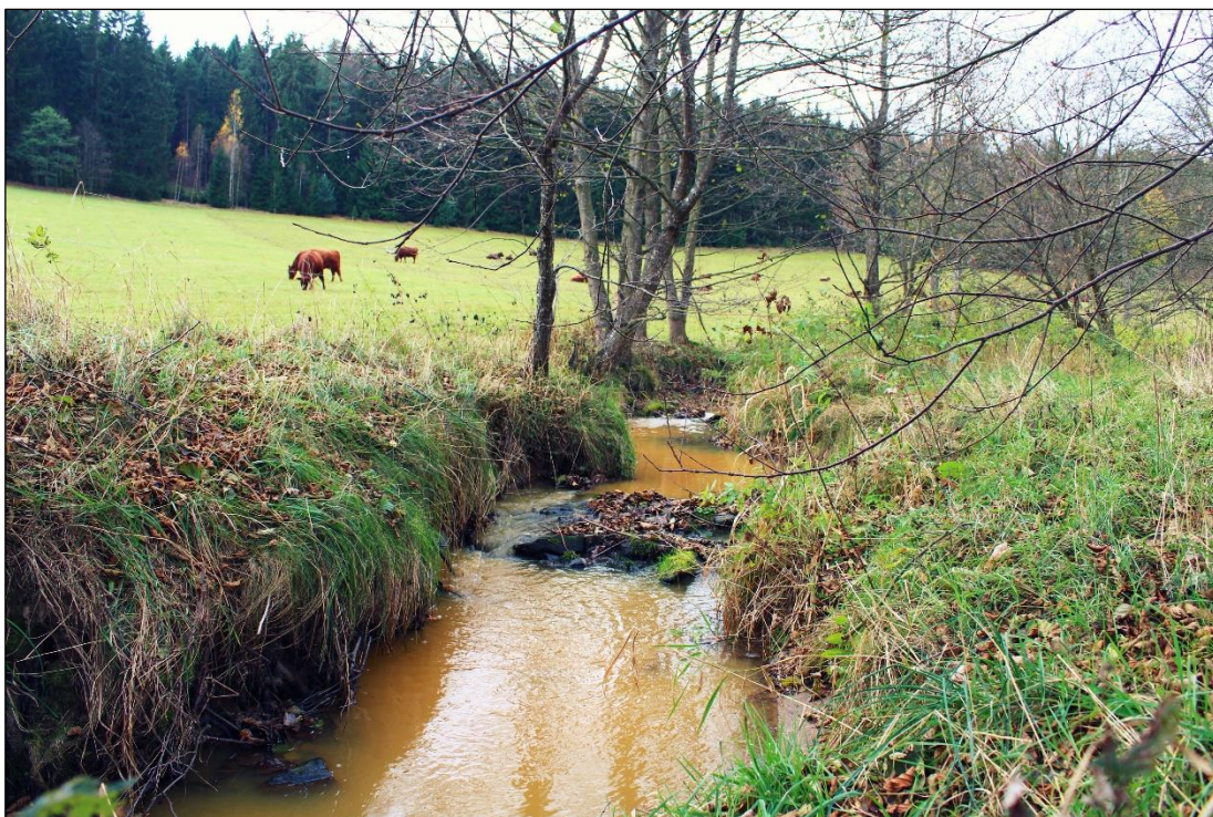
Obr. 30. Zpevnění dna kamenným pohozem, zdroj: vlastní (2.11.2017)
