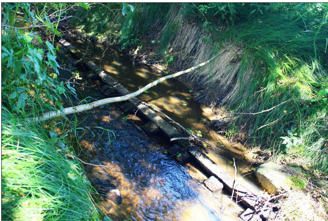
Obr. 23. Polovegetační tvárnice, drobné břehové nátrže (do 5 m), zdroj: vlastní (31.7.2017)
