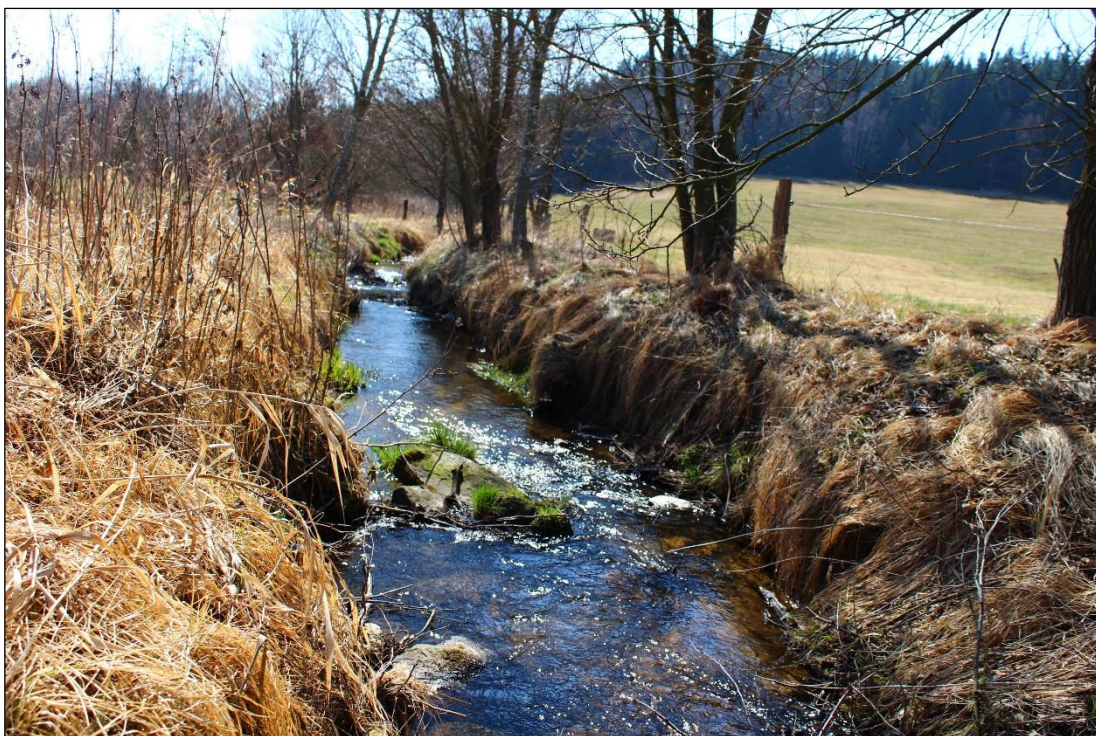
Obr. 42. Zpevnění dna kamenným pohozem, zdroj: vlastní (8.4.2018)
