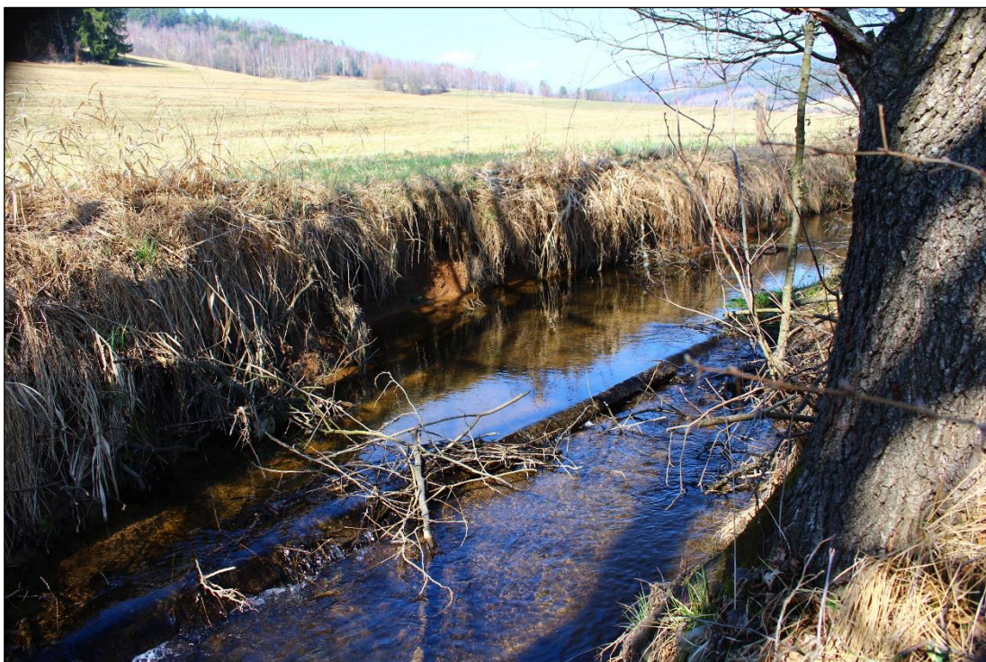
Obr. 46. Polovegetační tvárnice, drobné břehové nátrže (do 5 m), zdroj: vlastní (8.4.2018)
