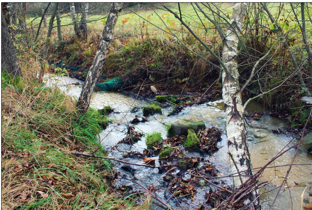
Obr. 34. Zpevnění dna kamenným pohozem, přejíznatý úsek zdroj: vlastní (2.11.2017)
