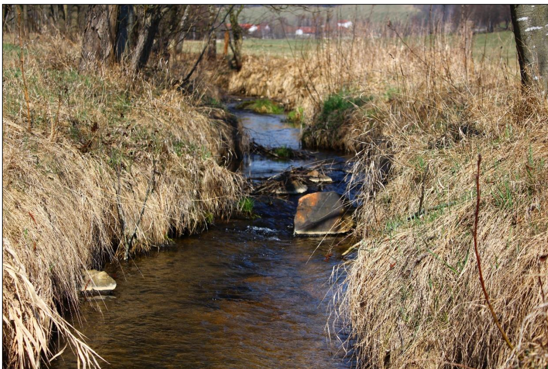
Obr. 41. Zpevnění dna kamenným pohozem, zdroj: vlastní (8.4.2018)
