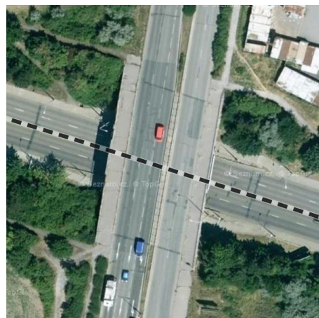
Obrázek 2.5 – Průjezd pod ulicí Černovická
