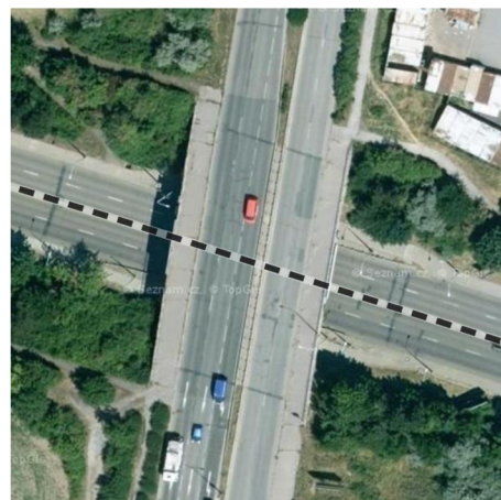
Obrázek 2.5 – Průjezd pod ulicí Černovická
