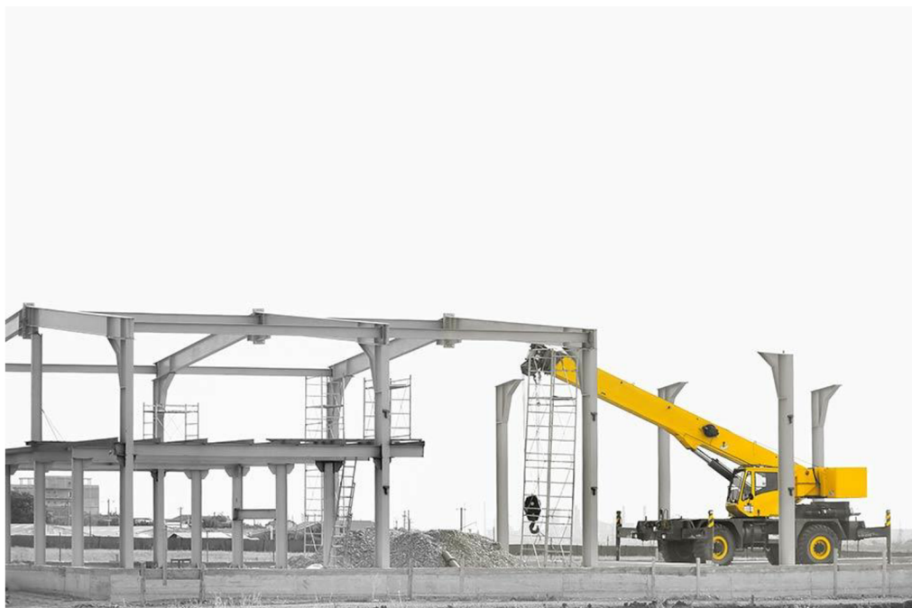
Obrázek 9.4 Montáž primární ocelové konstrukce
