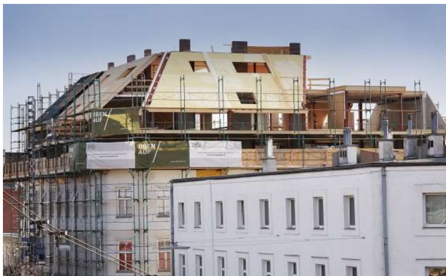
Obrázek 1 Realizace bytové nadstavby ve Vídni
