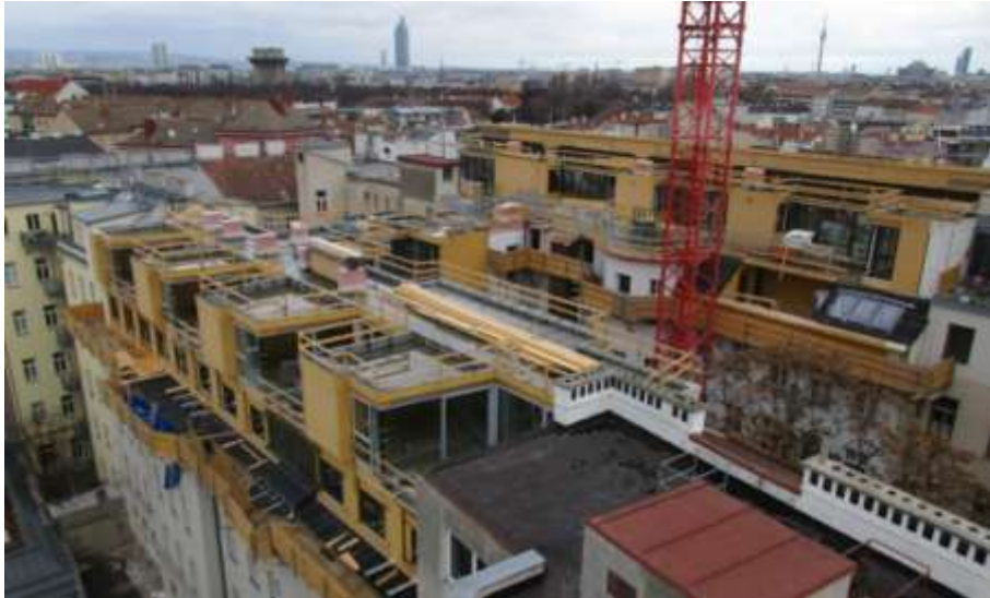
Obrázek 2 Průběh výstavby na střeše bytového domu
