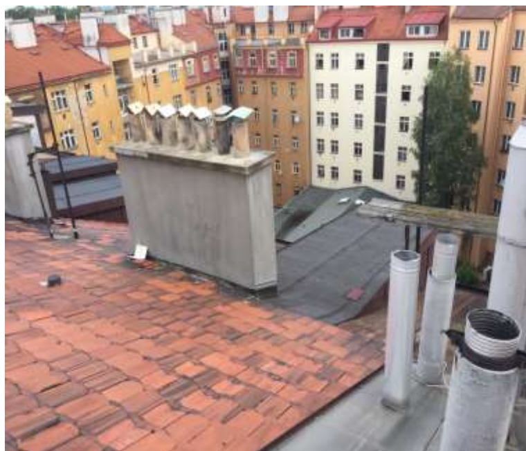
Obrázek 6 Pohled z hřebene střechy do dvora
