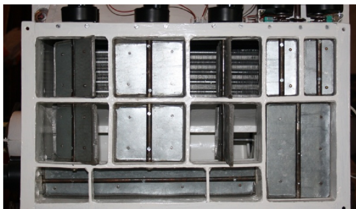
Obr. 53: Pohled na ventilační klapky distribuční skříně
