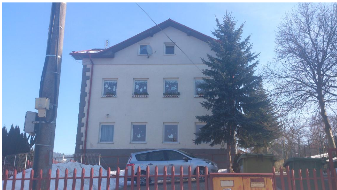
Obr. 1 Budova krízového centra Náruč
