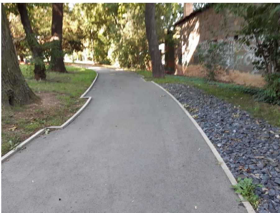
Obrázek č. 2 Cesta se sníženým obrubníkem, přes nějž srážková voda odtéká do boční šterkové drenáže (Kabelková, 2020)
