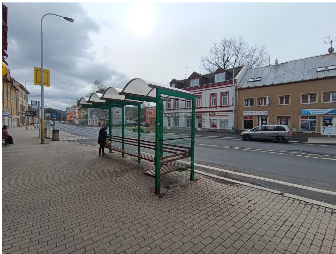
Fotografie č. 3 Stávající zastávka Rozcestí u Konička (vlastní fotografie)
