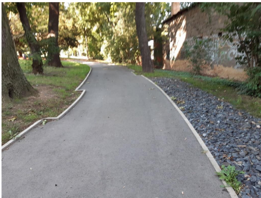
Obrázek č. 2 Cesta se sníženým obrubníkem, přes nějž srážková voda odtéká do boční šterkové drenáže (Kabelková, 2020)
