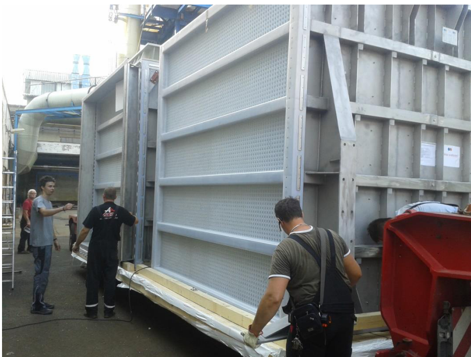
Obrázek 18 Sklotrubkový výměník W401 (2)
