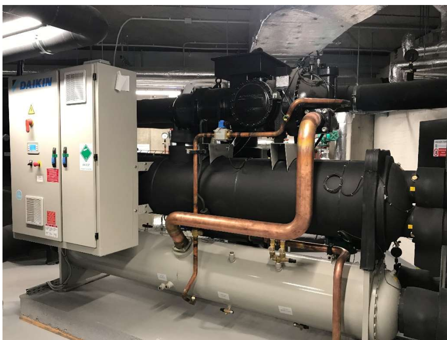
Obrázek 19: Chladicí jednotka DAIKIN [vlastní]
