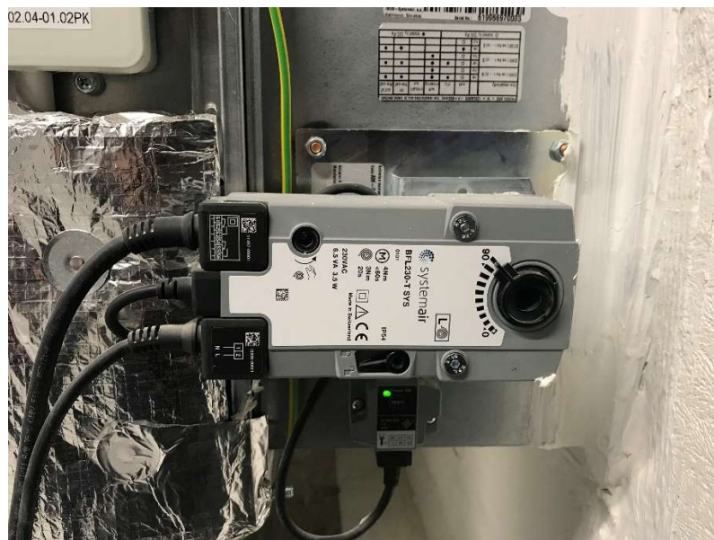
Obrázek 15: Protipožární klapka se servopohonem Systemair [vlastní]
