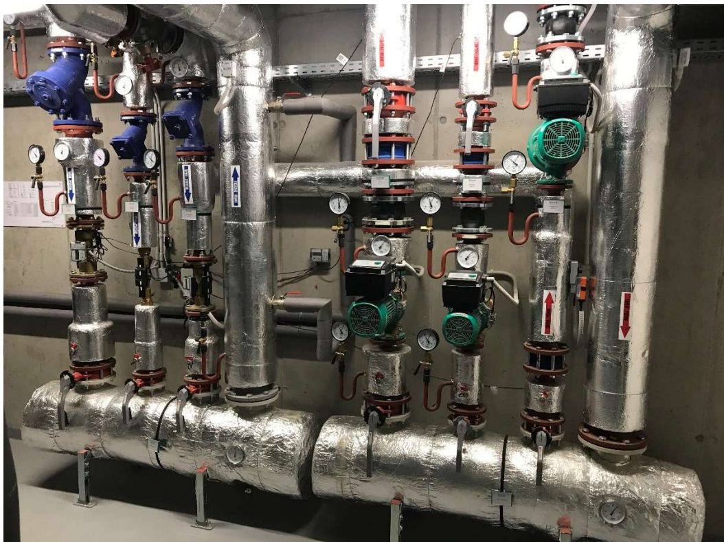
Obrázek 18: Rozdělovač s topnými okruhy [vlastní]
