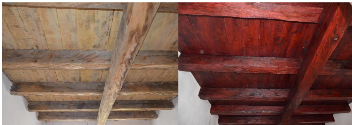
Obrázek 4: Strop před natřením a po natření recepturou na bázi krve
