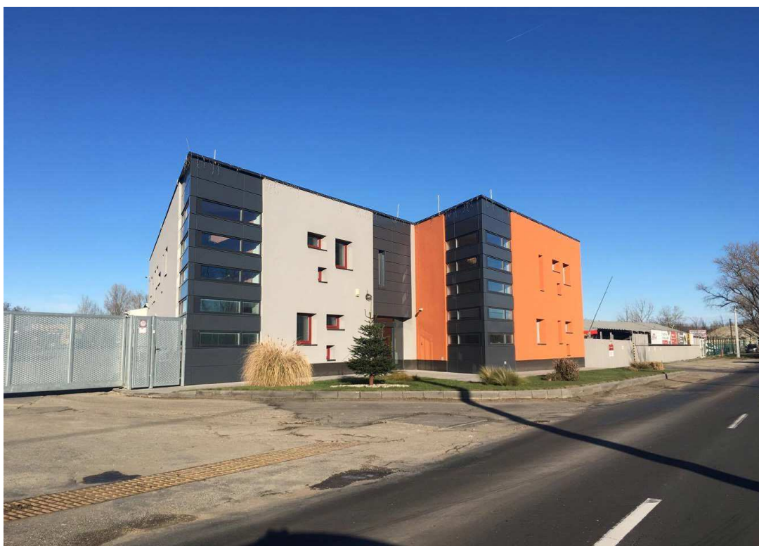
Obr. 9 Sídlo stavební firmy PLUS v Hodoníně na ulici Měšťanská
