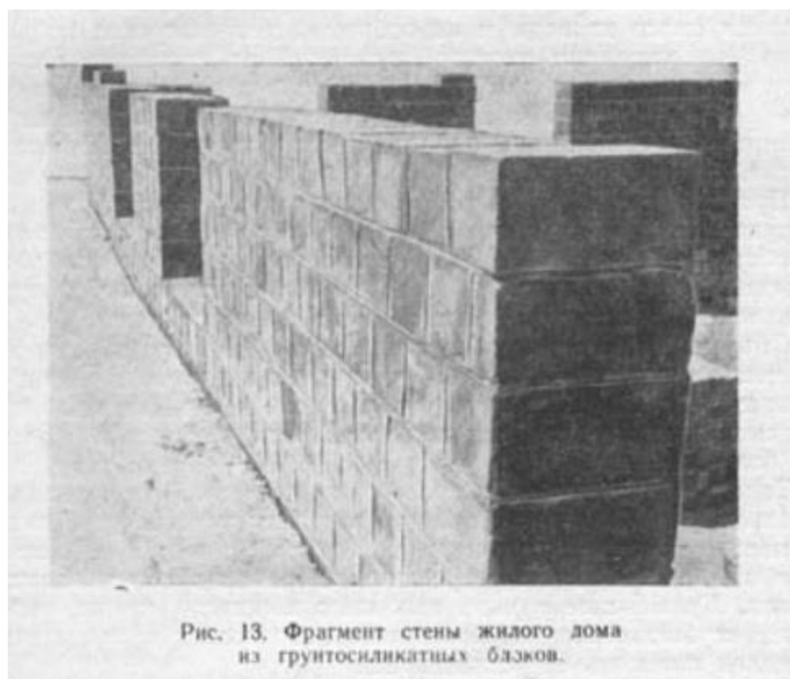
Obrázek 3: Část stavby z gruntosilikátových bloků [5]
