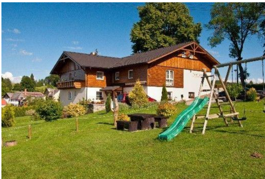
Obrázek 6 - Objekt penzionu U černého kohoutka
