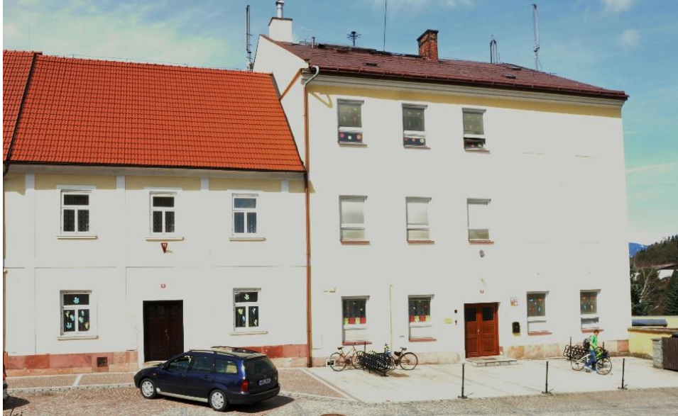
Abbildung 11: Schulhaus Nr. 34 (links) mit dem Schulkinderhof, Schulhaus Nr. 35 (rechts)
