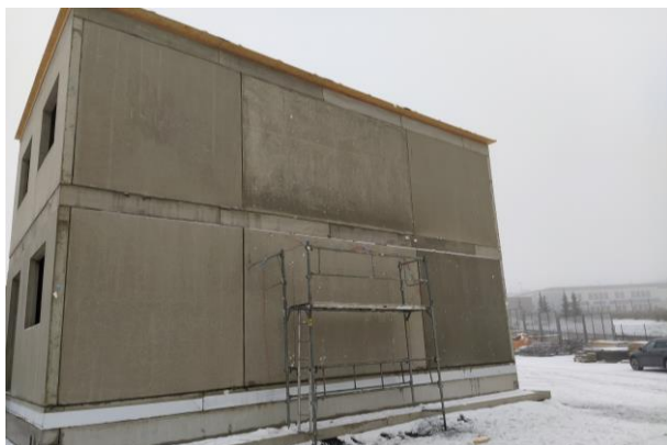
Obr. 4.14 Experimentální dům – před vyřezáním otvoru
