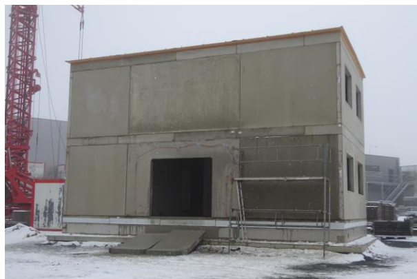
Obr. 4.15 Experimentální dům – po vyřezání otvoru
