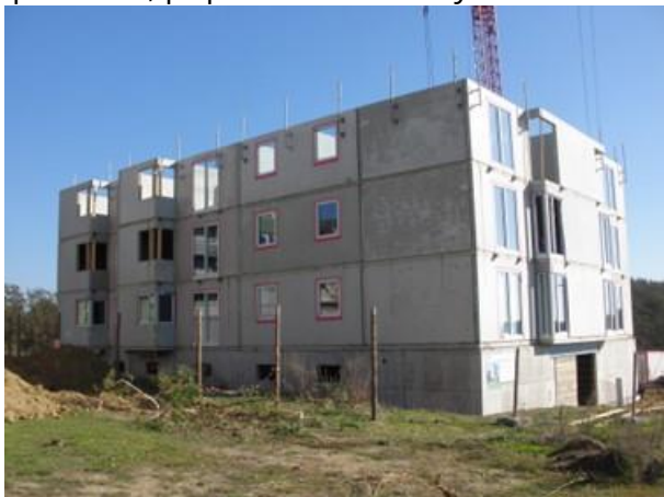
Obr. 2.1 Panelový dům (výstavba) [3]
