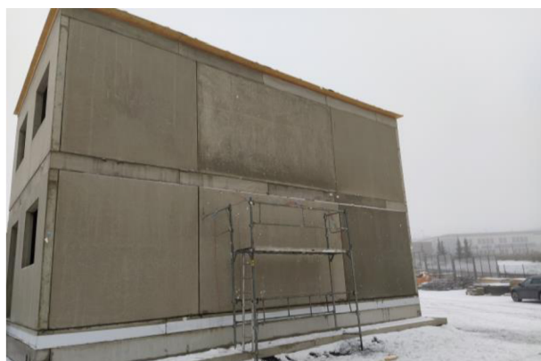
Obr. 4.14 Experimentální dům – před vyřezáním otvoru
