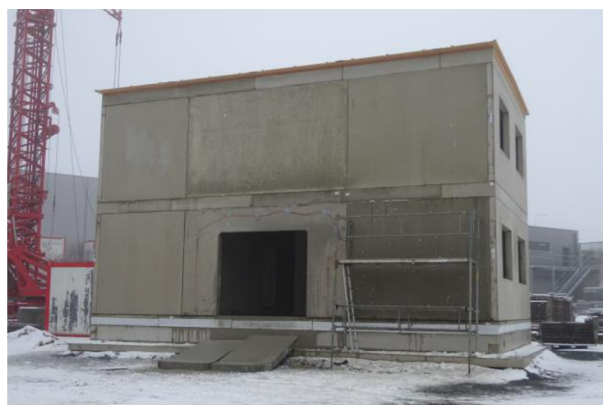
Obr. 4.15 Experimentální dům – po vyřezání otvoru
