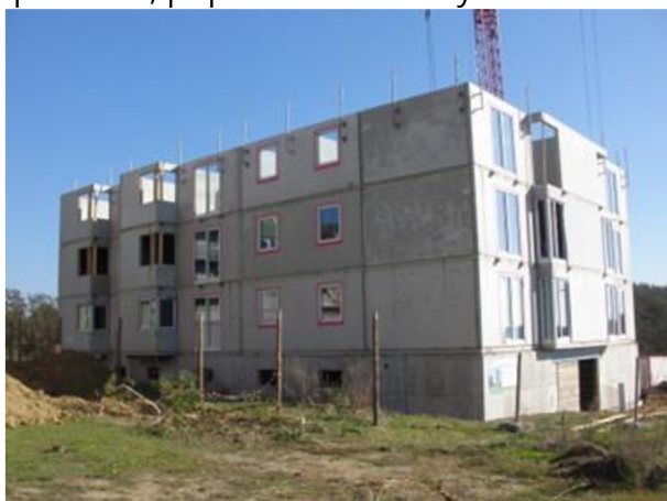
Obr. 2.1 Panelový dům (výstavba) [3]
