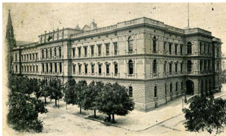
Obrázek 7 Budova Ústavního soudu v Brně (historická kresba)
