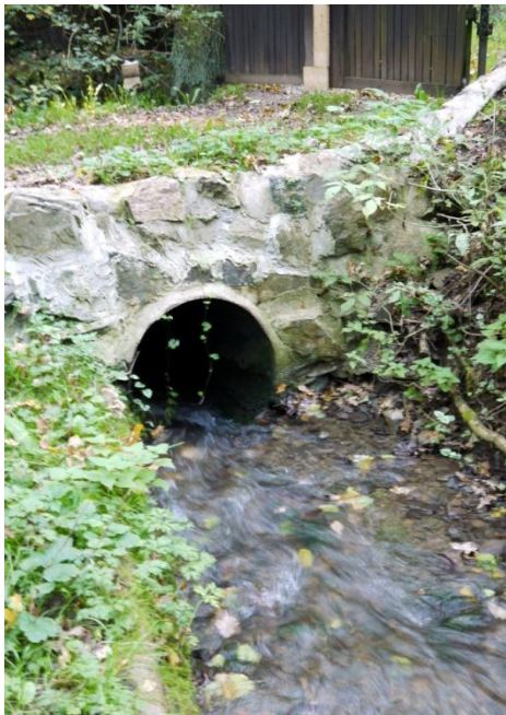
Foto č. 3: Ocelový propustek Drahaňského potoka (Vachatová, Závodská 2013).
