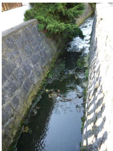
Foto č.5: Betonové dno se stěnami ze zdiva z lomového kamene – omítnutého (Vachatová, Závodská 2013).
