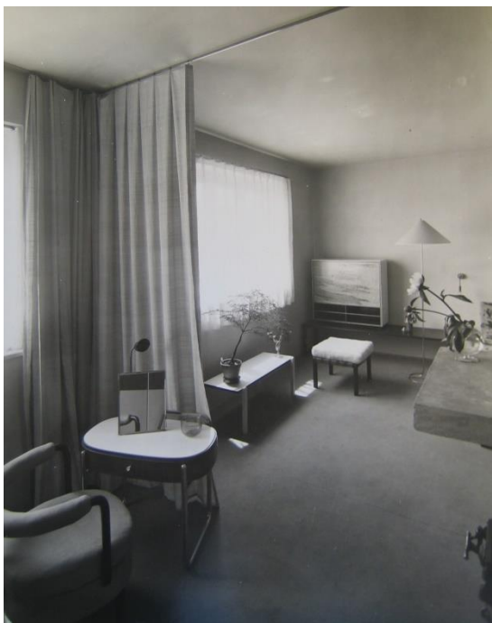
Obr. č. 62 Jacques Groag, dvojďum, Woinovichgasse 5,7, Werkbundsiedlung Wien , interiér, 1932
