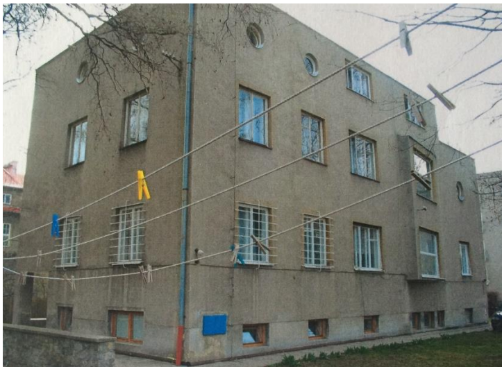
Obr. č. 34 Jacques Groag, dům pro rodinu Briessových, Na Vozovce č. o. 12, č. p. 549, Olomouc, zahradní průčelí, 2006
