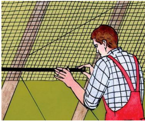
Obr. 54: Napojení pásů parozábrany (zdroj: [43])
