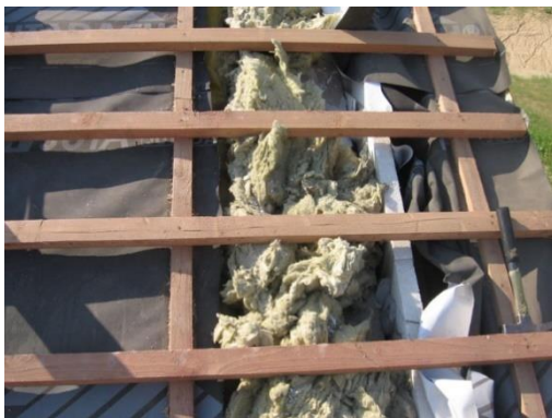
Obr. 66: Rozpad minerální vlny vlivem infiltrace (zdroj: [50])
