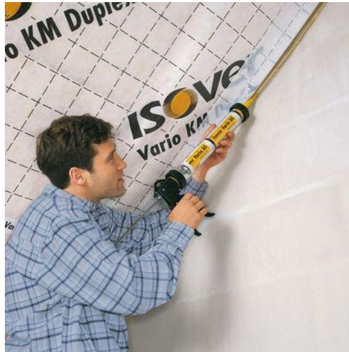
Obr. 58: Spojení tmelem s navazující konstrukcí (zdroj: [44])
