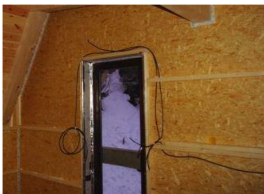
Obr. 52: Vzduchotěsná vrstva z OSB (zdroj: [42])
