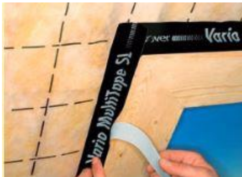
Obr. 56: Napojení parozábrany na okenní rám (zdroj: [44])
