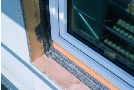
Obr. 64: Správné napojení parozábrany na okenní rám 1 (zdroj: [48])
