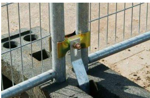
Obr. 22: Pojistka proti vyháknutí (zdroj: [16])
