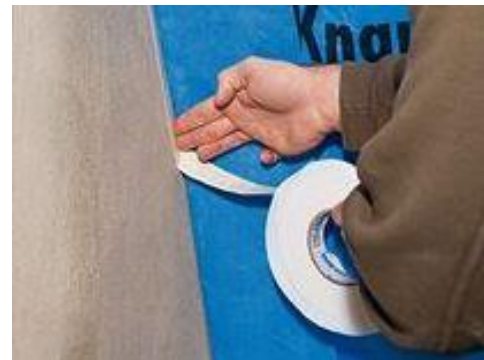
Obr. 57: Spojení páskou s navazující konstrukcí (zdroj: [45])
