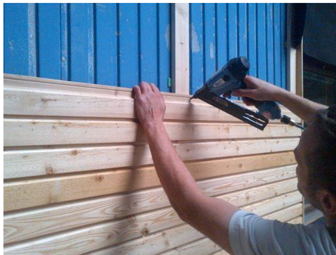
Obr. 15: Montáž palubek (zdroj: [11])
