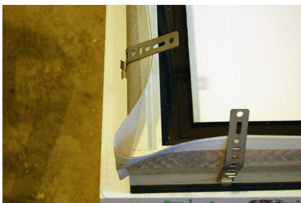
Obr. 5: Montáž pásových kotev (zdroj: [3])
