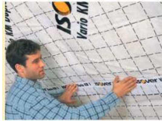
Obr. 55: Zalepení kotvicích prvků páskou (zdroj: [44])
