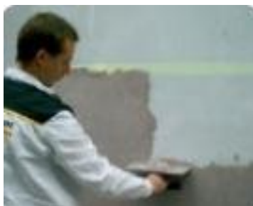
Obr. 21: Nanášení tenkovrstvé omítky (zdroj: [15])
