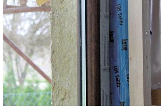
Obr. 65: Správné napojení parozábrany na okenní rám 2 (zdroj: [49])
